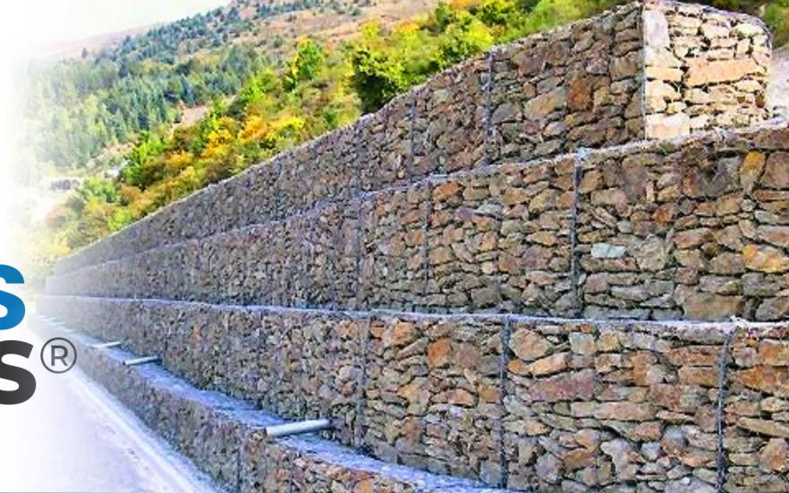
Los gaviones están formados por la combinación de un refuerzo en malla hexagonal doble torsión que se produce a partir de alambres de acero y recubrimiento galvanizado, especialmente desarrollado para obras de ingeniería.
